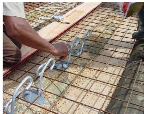
Figura A50 – Instalação dos conectores
