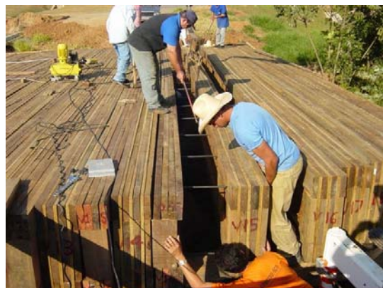
Figura A61 – Instalação das barras de protensão
