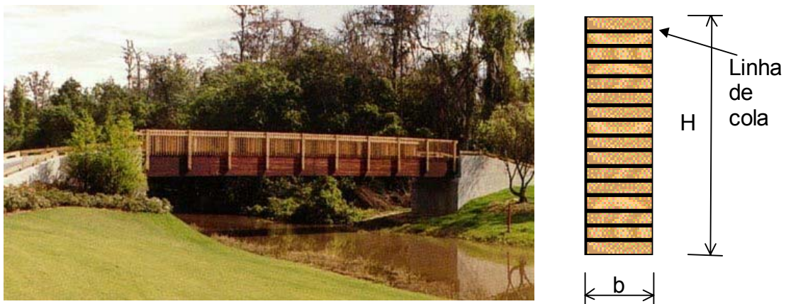
Figura 4.5 – Ponte com Vigas Laminadas Coladas
