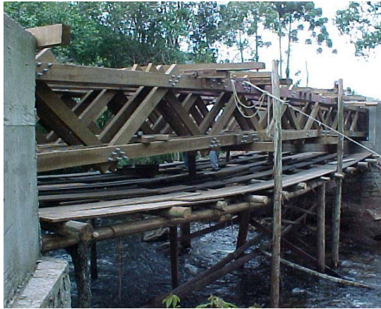
Figura A2 - Vista lateral da ponte
