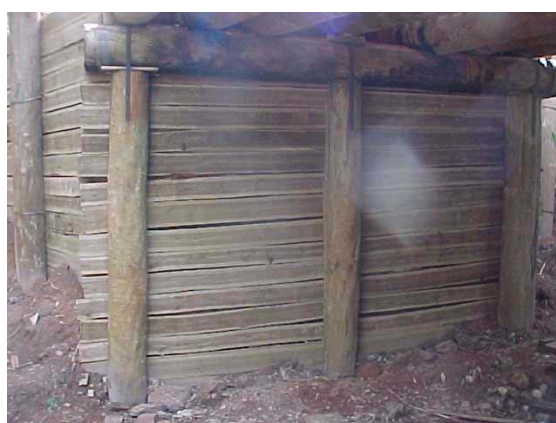
Figura A27 - Vista das fundações
