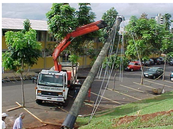
Figura A43 – Içamento do mastro
