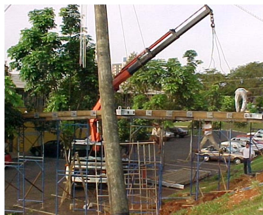
Figura A44 – Içamento dos módulos
