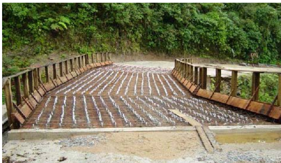
Figura A17 – Vista superior do tabuleiro com os conectores metálicos
