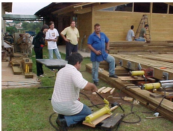
Figura A40 – Aplicação de protensão
