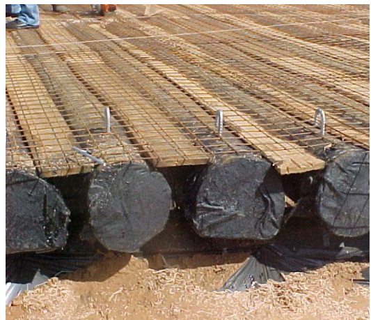
Figura A36 – Detalhe de proteção dos tops
