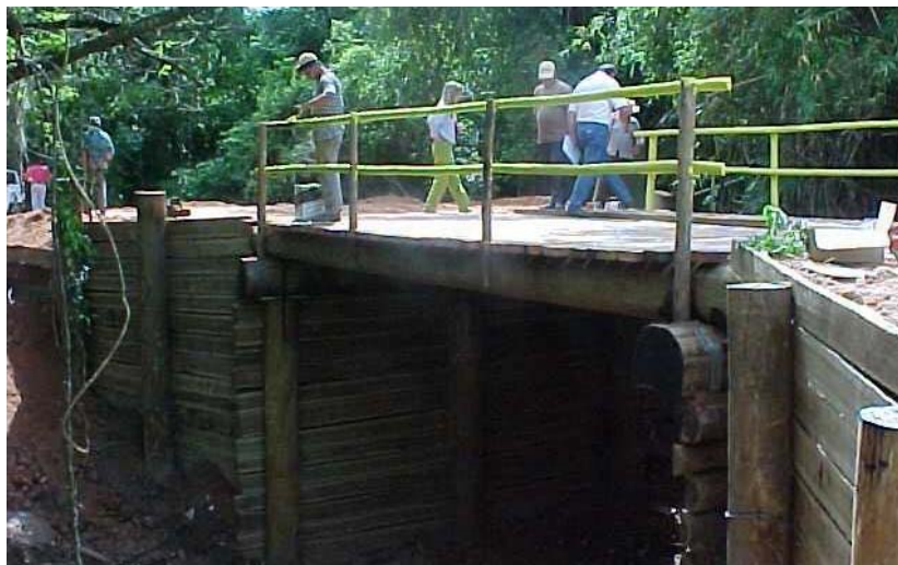
Figura A22 - Vista da Ponte Estrada Floresta
