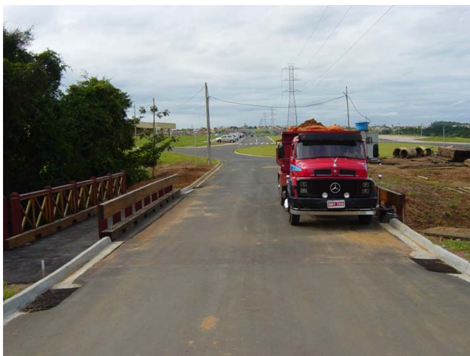
Figura A57 – Vista da Ponte 03
