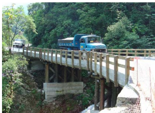
Figura A15 – Prova de carga na lateral esquerda
