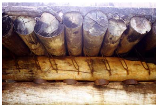
Figura 5.8 - Tabuleiros compostos de peças roliças de madeira e concreto
