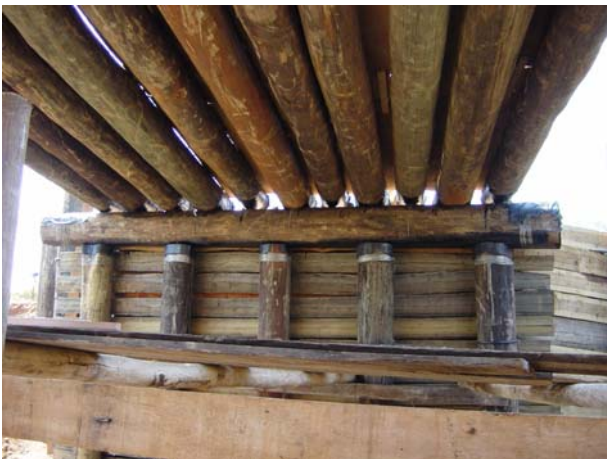
Figura A35 – Posicionamento das longarinas
