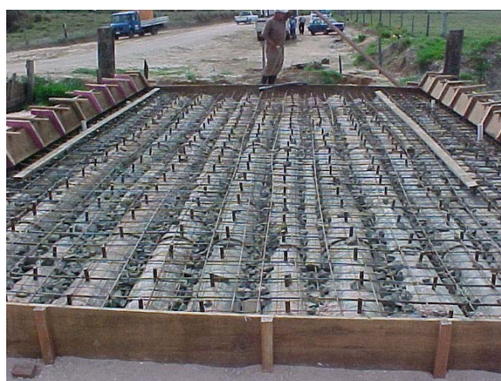
Figura A21 – Vista superior do tabuleiro com os conectores metálicos
