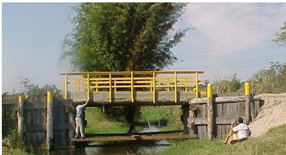
Figura A28 - Vista da Ponte Florestinha
