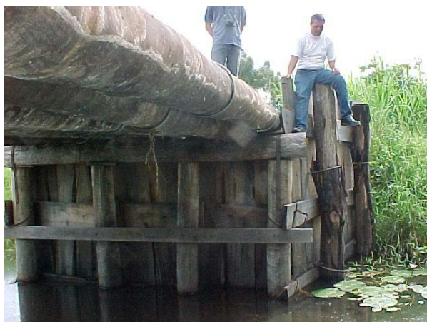
Figura A29 – Vista inferior do tabuleiro
