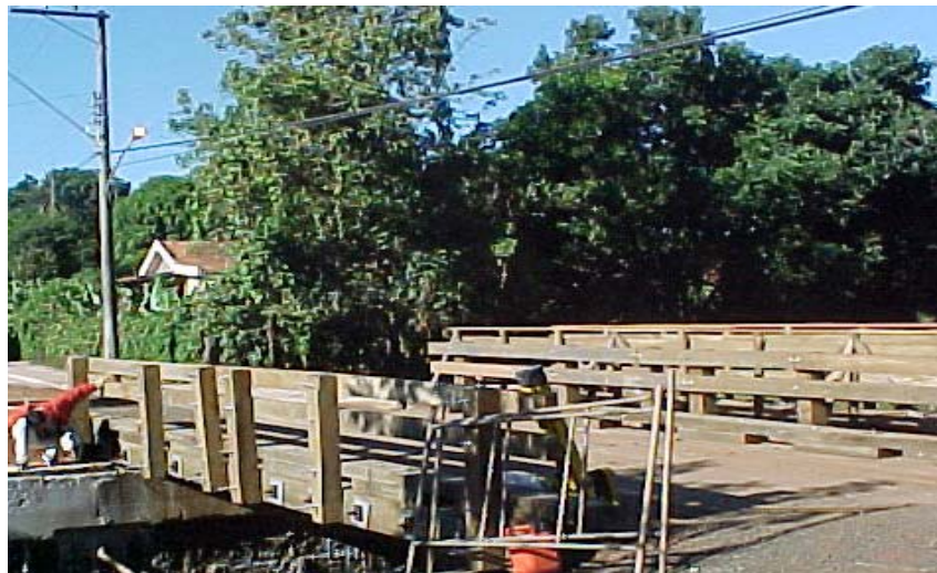
Figura A39 – Vista da Ponte Monjolinho
