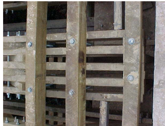
Figura A5 - Fixação das transversinas
