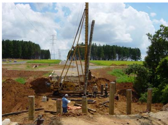
Figura A58 – Cravação das estacas
