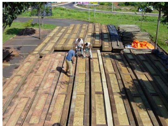
Figura A59 – Montagem das vigas compostas
