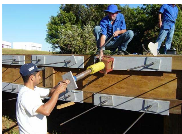
Figura A62 – Aplicação da força de protensão
