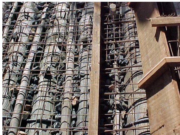
Figura A30 – Vista das ferragens do tabuleiro
