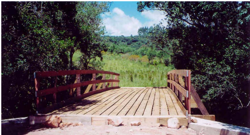
Figura A1 - Vista da Ponte Aiuroca
