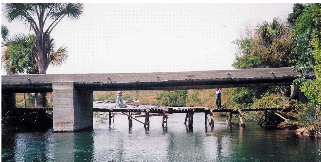
Figura A6 - Vista da Ponte Batalha
