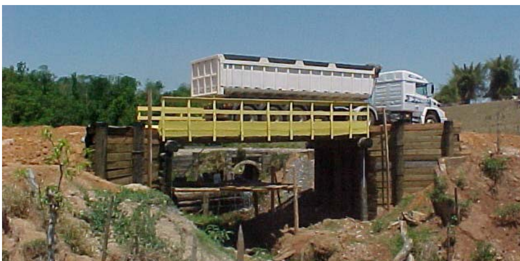
Figura A38 – Vista da Ponte Paredão Vermelho
