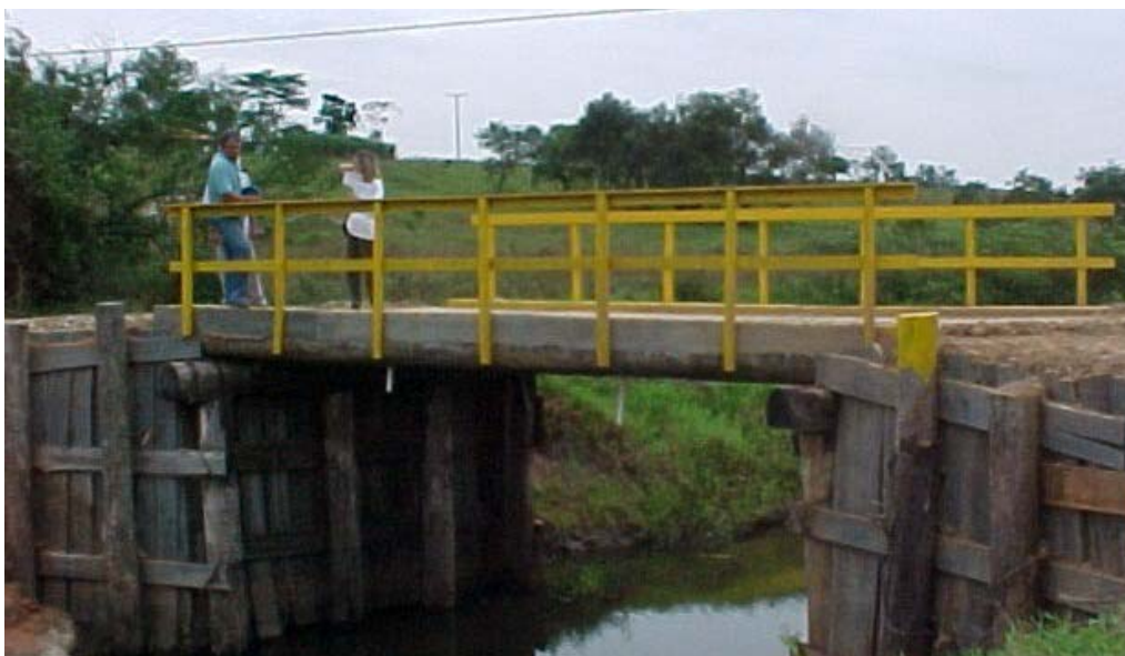
Figura A32 – Vista da Ponte Ibitiruna
