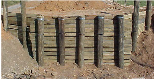
Figura A34 – Fundação concluída
