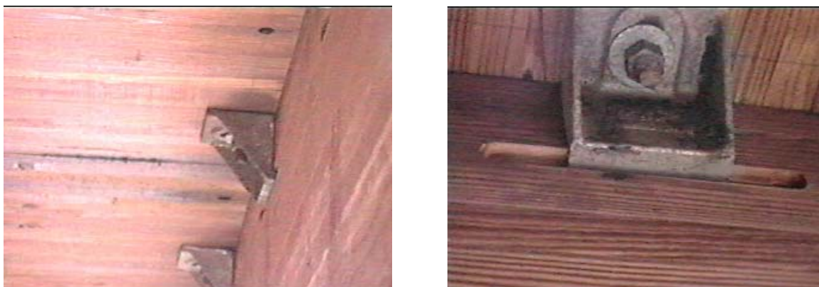
Figura 5.5 – Ligação dos tabuleiros de madeira laminada colada
