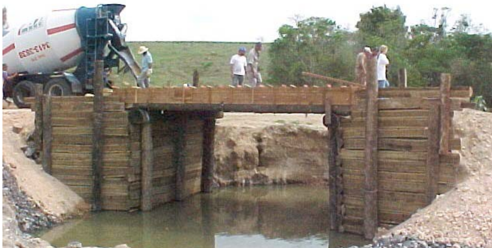
Figura A18 - Vista da Ponte Capela
