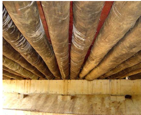
Figura A48 – Vista inferior do tabuleiro
