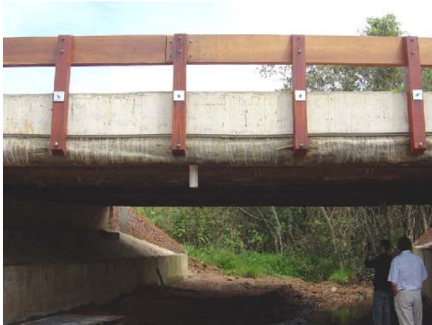
Figura A47 – Vista lateral da ponte
