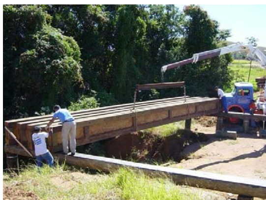
Figura A60 – Posicionamento das vigas
