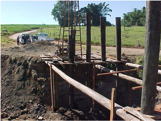
Figura A33 – Cravação das estacas
