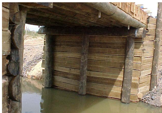
Figura A20 – Vista das fundações
