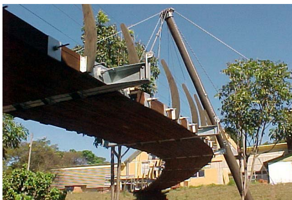
Figura A41 – Vista inferior do tabuleiro
