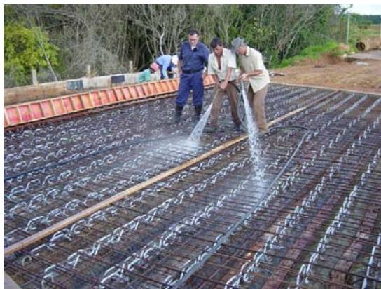
Figura A55 – Preparação para a concretagem
