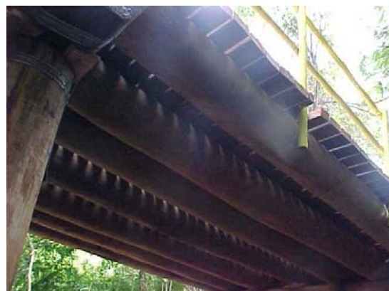
Figura A26 – Vista inferior do tabuleiro
